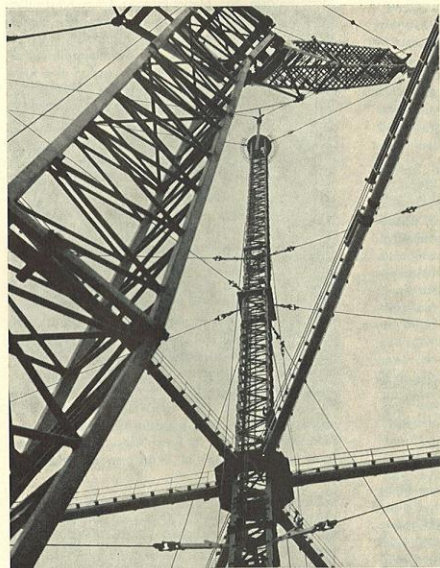
Bild 1 Breitband-Reusenantenne während der Montage; Frequenzbereich 0,5 bis 5 MHz; aufnehmbare Leistung 350 kW; Höhe 144 m. Die Antenne wurde von Rohde & Schwarz für die Deutsche Bundespost geliefert. Statik und Stahlbauarbeiten: Hein, Lehmann und Co. AG, Düsseldorf. Foto: Woscidlo Ffm Nr. 001 053/8
