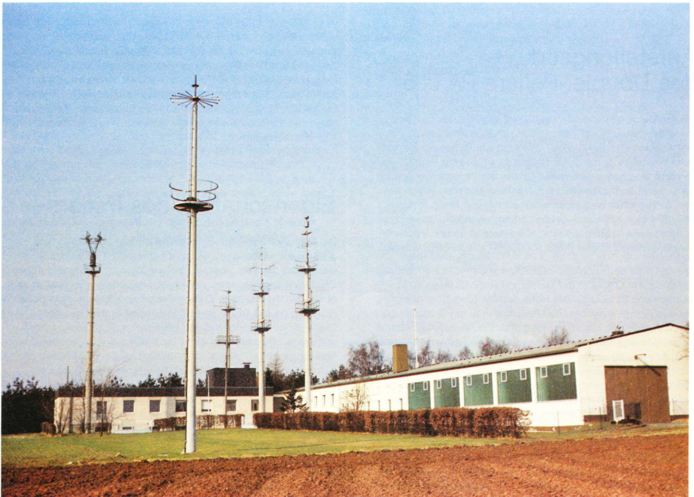
BILD 1 Antennensystem 20 bis 200 MHz des Breitband-Doppler-Peilers PA 005 im Gelände der Funkkontrollmeßstelle Krefeld.
