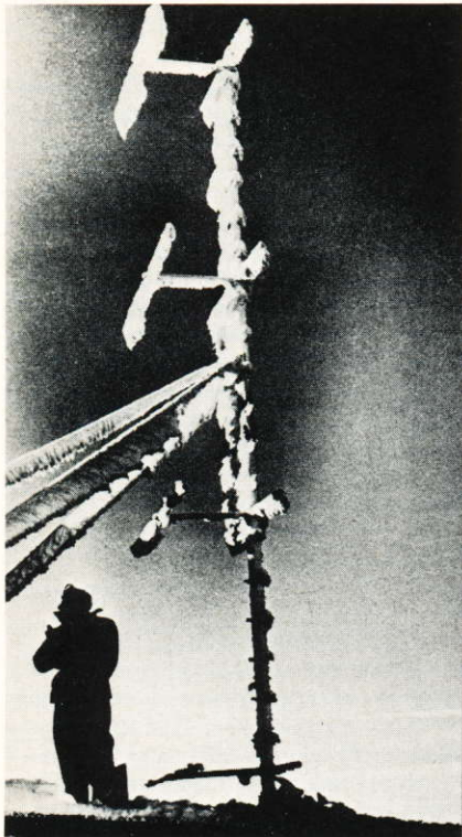
Dr. Rohde beim Aufstieg zur ersten hochalpinen UKW-Richtstrahlantenne, die R&S 1950 auf dem 1840 m hohen Wendelstein errichtete. Mit solchen stark bündelnden Richtstrahlern wurde ein Optimum an Feldstärke in dichtbesiedelten Gebieten erzielt, so daß man dort auch schon mit einfachen und billigen UKW-Geräten einen ausgezeichneten Empfang hatte — eine der Voraussetzungen für den erstaunlich schnellen Siegeszug der »Welle der Freude«.
