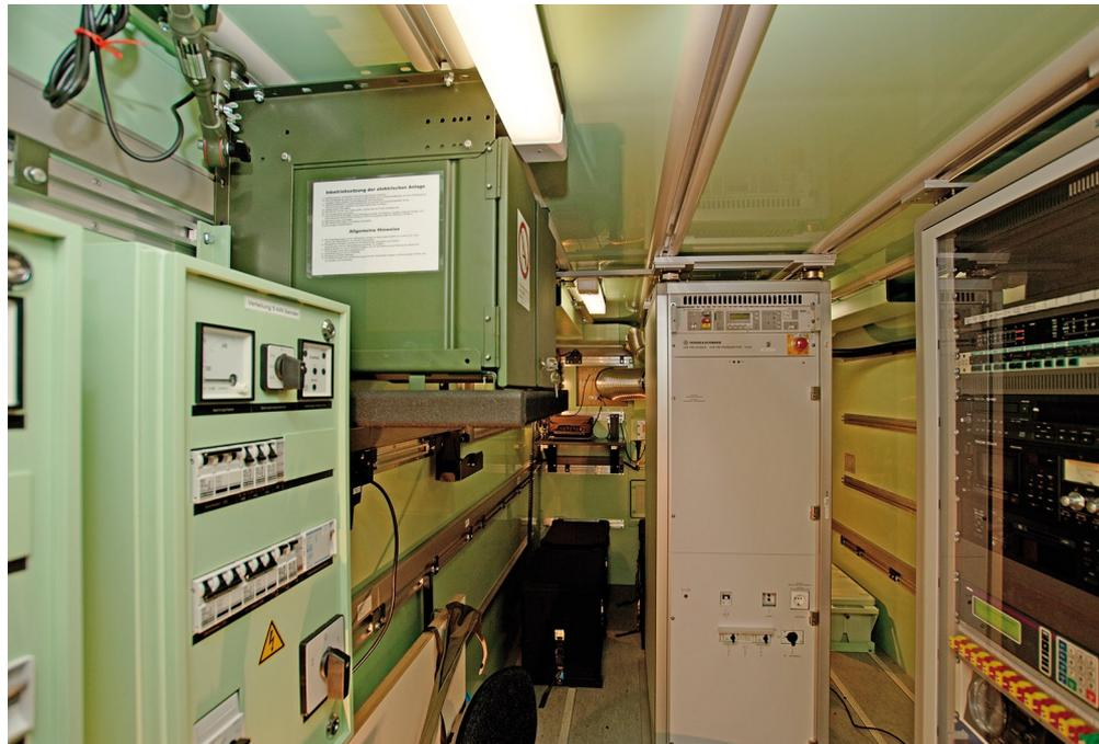
**BILD 2** Die Sendekabine mit den Stromverteilungen (links), dem UKW-Sender (Mitte) und dem System zur Notprogrammversorgung (rechts).
